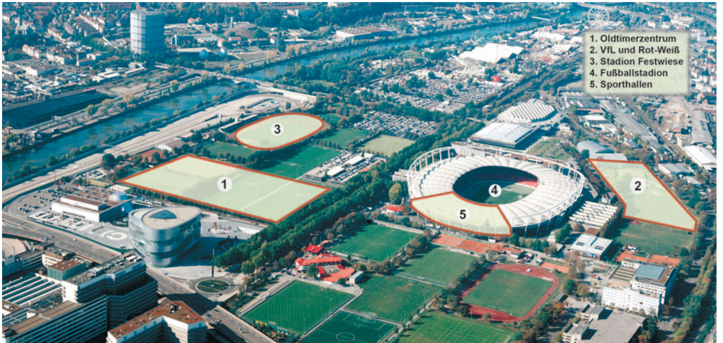
Der Neckarpark steht vor großen Veränderungen: Den Anfang soll die Verlagerung des VfL Stuttgart (von 1 nach 2) machen, die Festwiese (3) und das Stadion (4) sollen umgebaut werden. Eine Sporthalle ist geplant (5). Foto Storck, Bildservice
